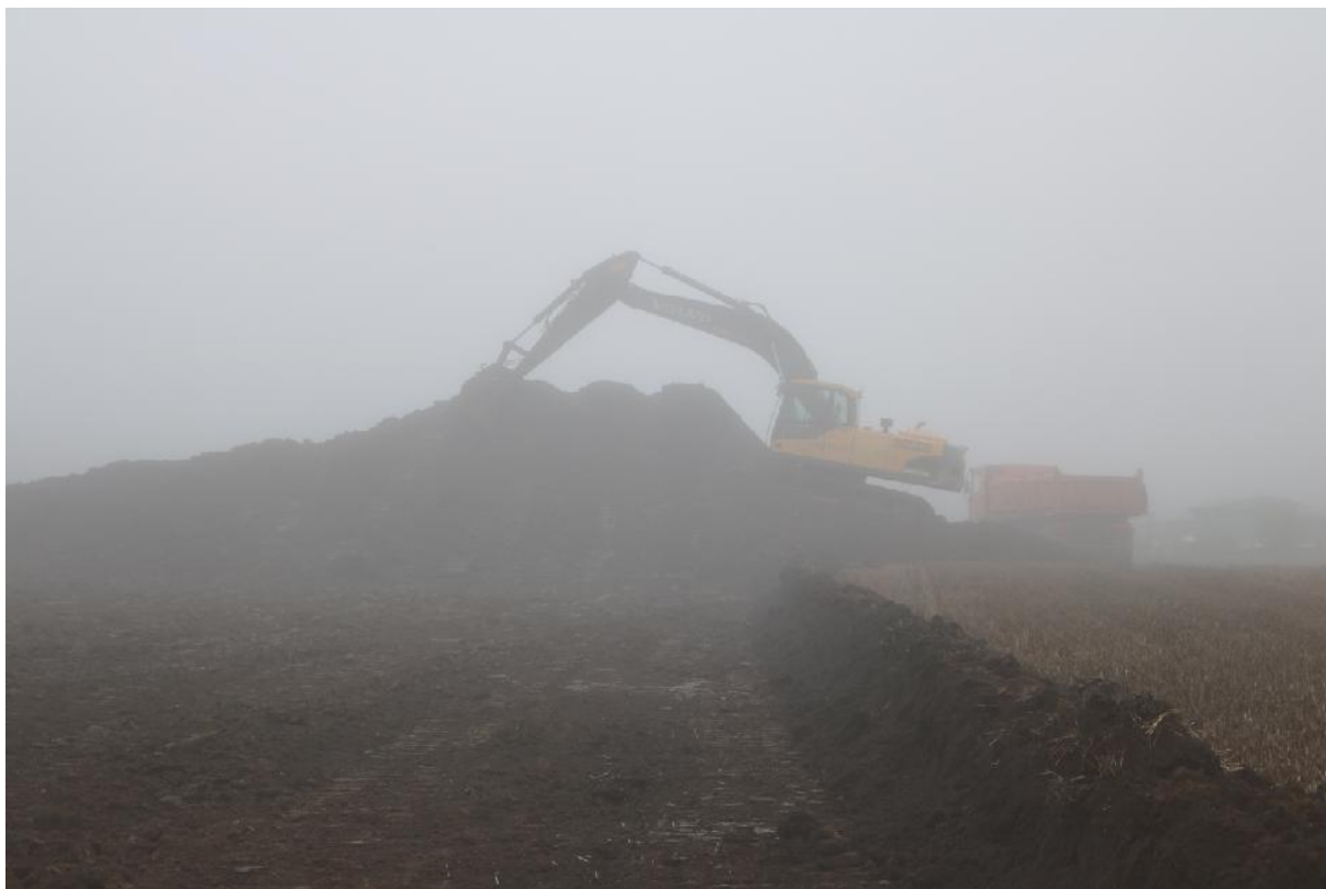
Ostrovačice: Práce na skrývce před zahájením archeologického výzkumu
