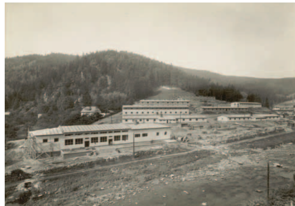
Stavba ubytoven pro dělníky. Vír (okr. Žďár nad Sázavou), 1948. MZA, f. 483 Povodí Moravy.
