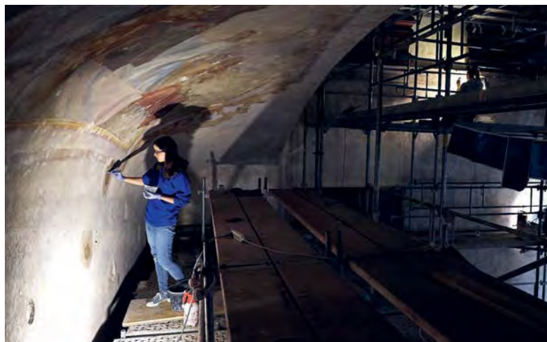
Práce ve výškách se restaurátoři nesmějí bát. ▲
