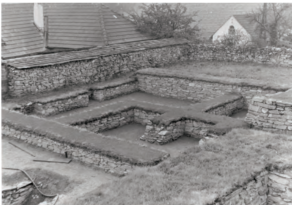
Obr. 11, 12. Postupná konzervace základů tvrže zpevněním a zadrnováním v říjnu 1962 a její dokončení v r. 1963. Archiv LO MM-3/97-366, 303.
